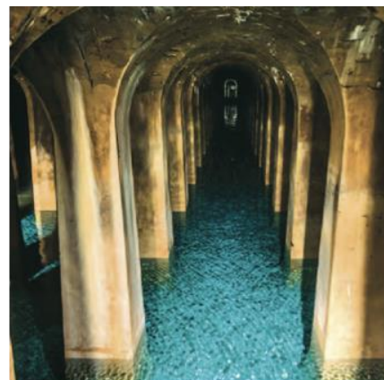
Réservoir de Montsouris à Paris
