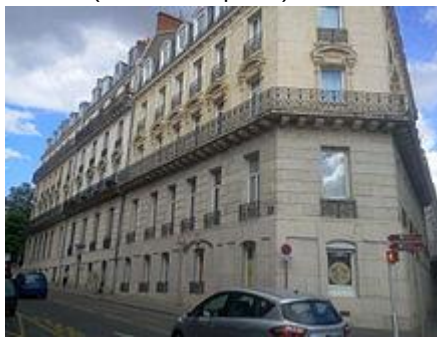
Immeubles à Dijon
