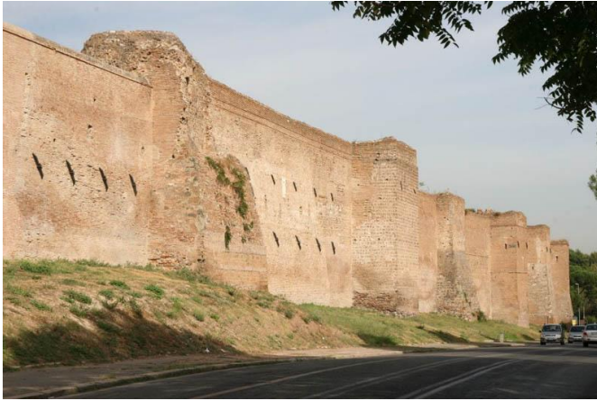
Le mur d'Aurélien, enceinte de Rome sous l'empire, IIIe s
