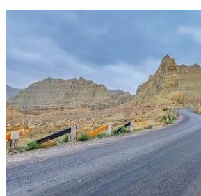
g. Autoroute ①
